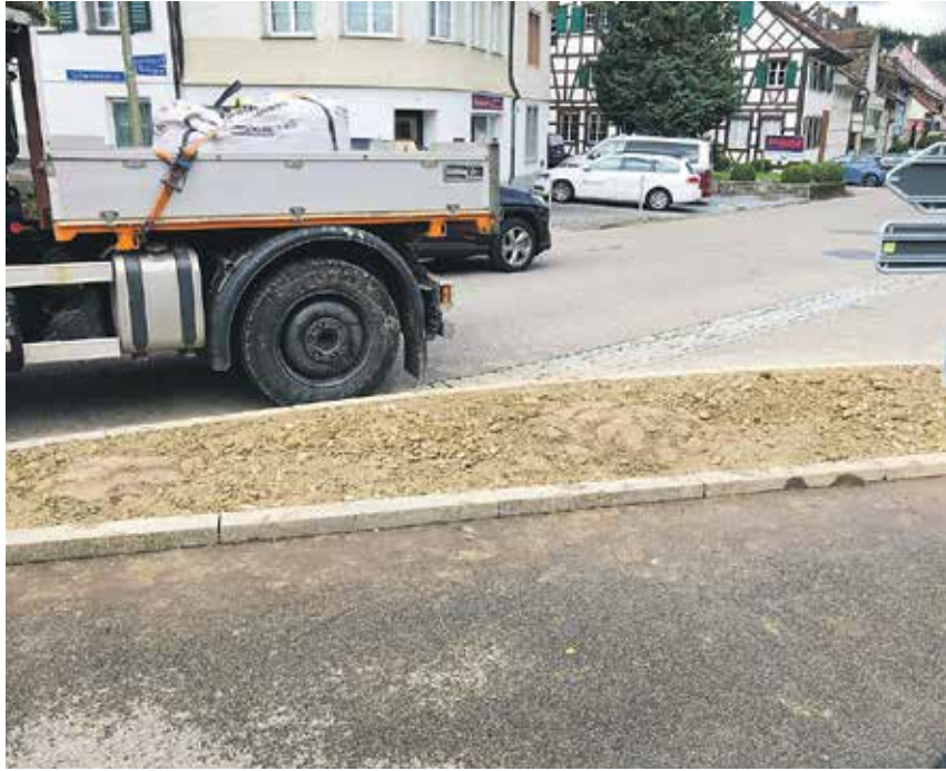
Aufgefüllt mit Wandkies und den beiden Wildbienenandflächen.
